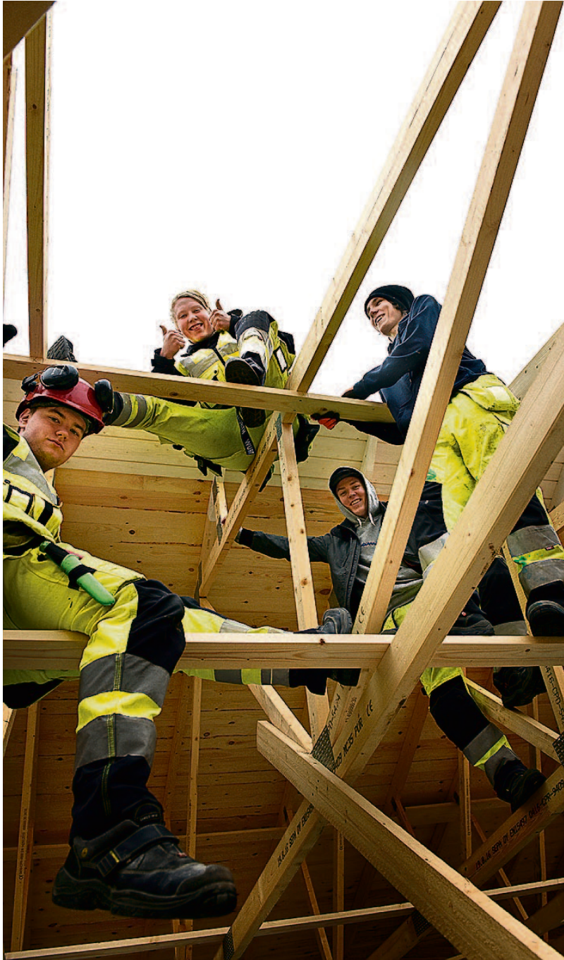
Frans Hansson, Erik Kenttä, Robin Nordman och Johannes Mattsson är i full gång med att göra klart underlags-taket.
