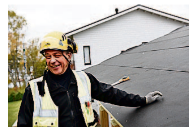
Handledare Bror-Gustav Haasiosalo har varit lärare på bygglinjens i 32 år och tycker att råspont och filt är ett bra underlag. "Jag har sett alltför många billiga och kortlivade alternativ när det kommer till tak", säger han.
