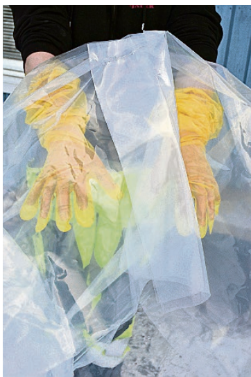
"Om en liten rörbit i ett pannrum behöver saneras använder man påssaneringsmetoden", förklarar Dick Sederström. Foto: Norah Lång
